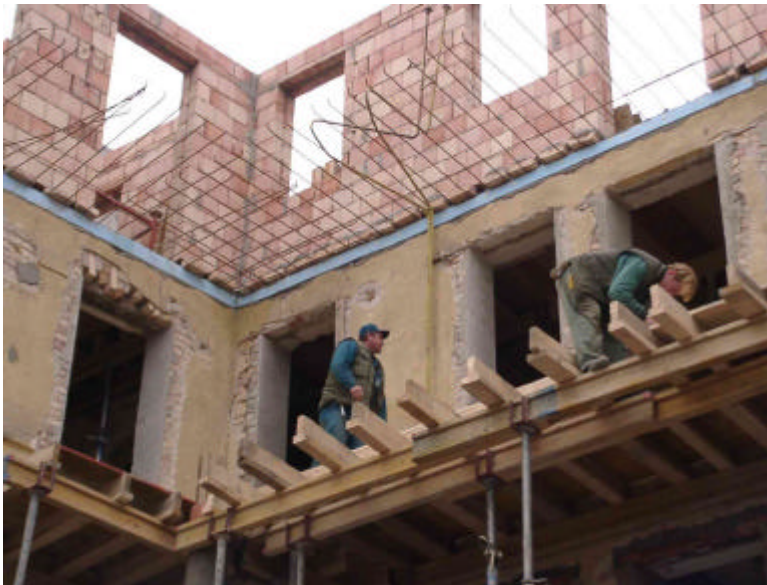
Rénovation d'un ancien bâtiment à Budapest, Hongrie. Réutilisation et adaptation d'un bâtiment en ajoutant un étage.
