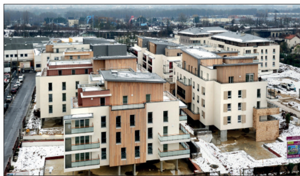
"Les Terrasses d'Attégia", 139 logements en accession sociale par Expansiel Promotion à Athis-Mons (91).
